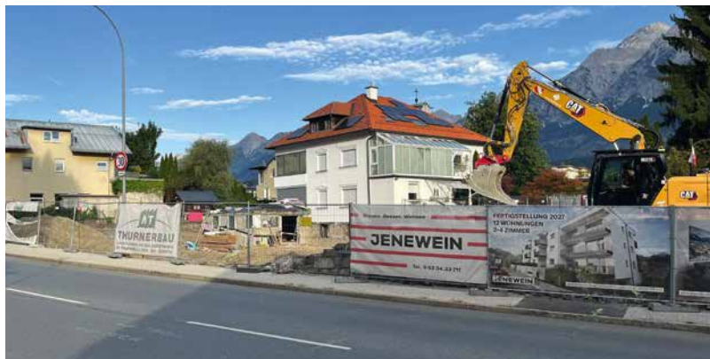
Die Bauarbeiten an der Wohnanlage Innsbrucker Straße haben begonnen
