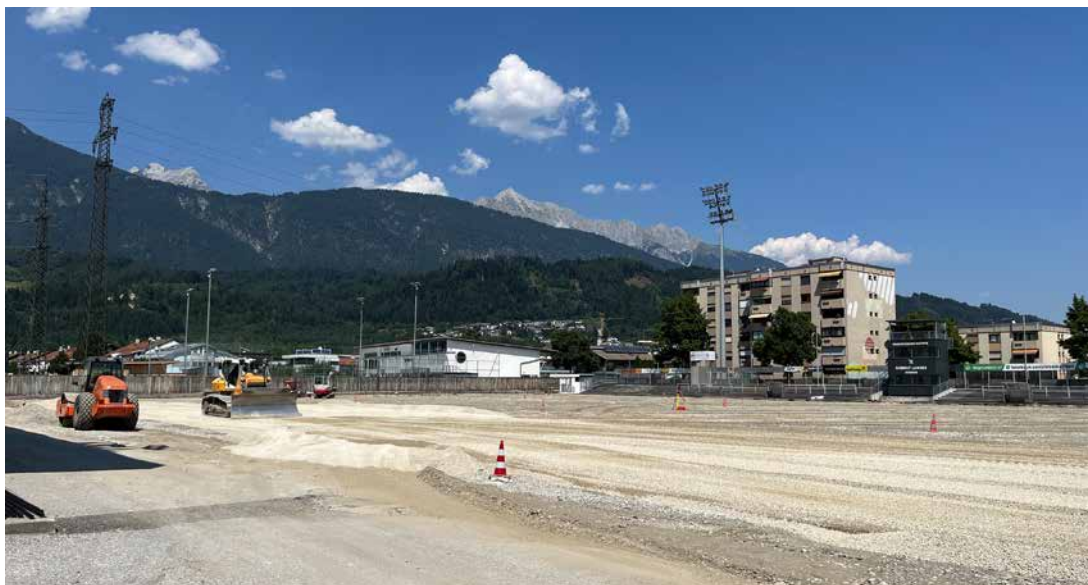
Die begonnenen Arbeiten am Stadionrasen (Rasenheizung) sollen trotz der Ablehnung einer Haftungsübernahme abgeschlossen werden
