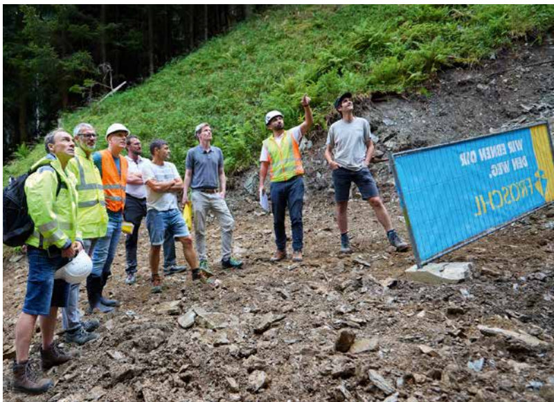
Bürgermeister Lukas Schmied (3.v.r.) mit Ortsvorsteher Christian Singer, Projektleiter Richard Dallarosa, Planern und ausführenden Firmen bei der Baustellenbesichtigung
