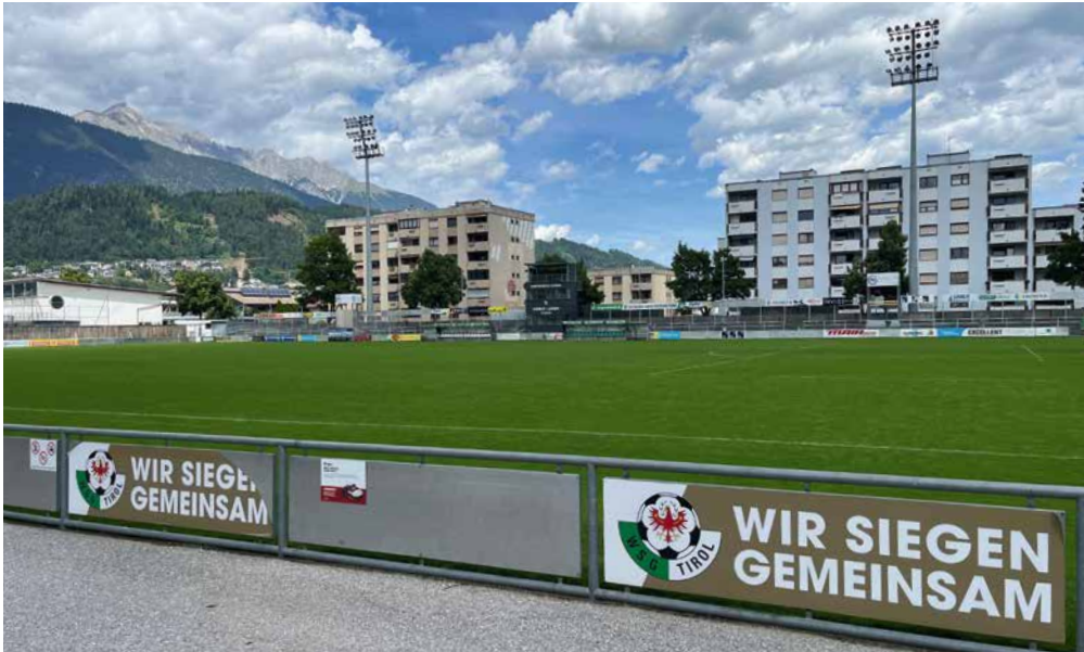
Die ersten Arbeiten für die bundesligataugliche Adaptierung des Gernot-Langes-Stadions starten Ende Juni mit dem Abtrag der Rasenfläche
