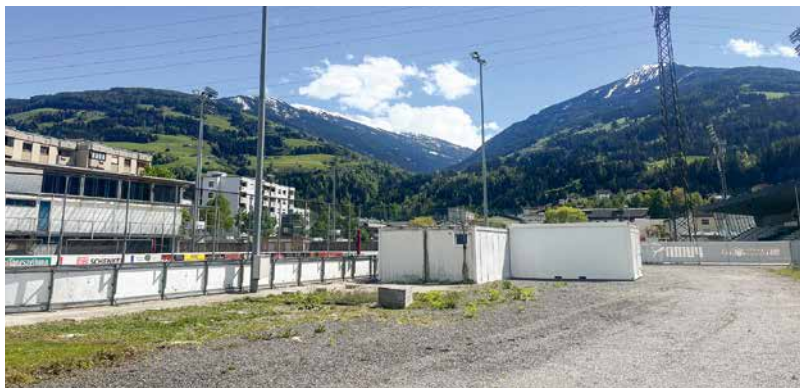
Das Container-Provisorium ist Geschichte, bis zum Herbst entsteht hier ein neues Kabinengebäude in Holzmassivbauweise.
