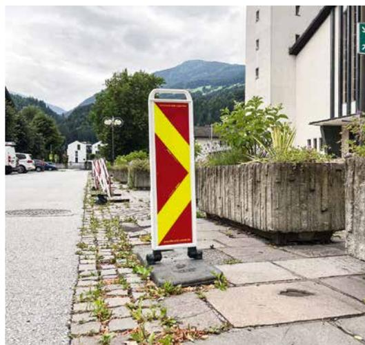
*Die beschädigte Pflasterung entlang des Fahrstreifens am Marienplatz muss saniert werden*
